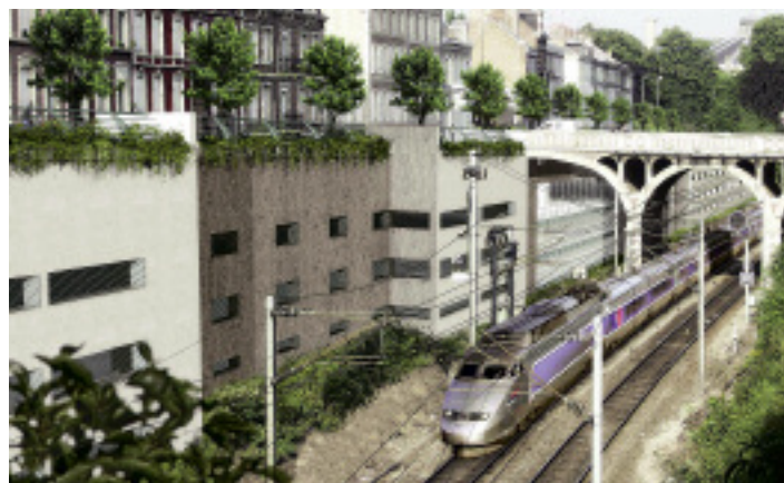
En bordure de la voie ferrée, le futur parking Jules Verne offrira 350 places, permettant de mettre fin au stationnement sauvage sur les boulevards intérieurs.
