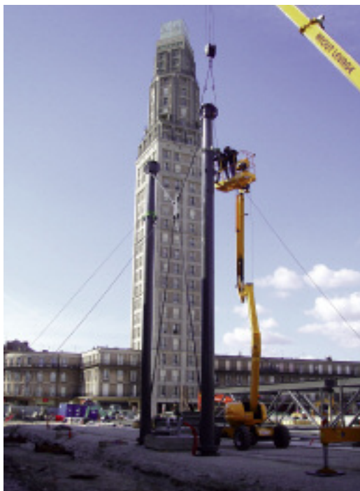
La pose des pylônes de la charpente qui soutiendra la verrière s'effectue grâce à l'utilisation d'une grue automotrice.
